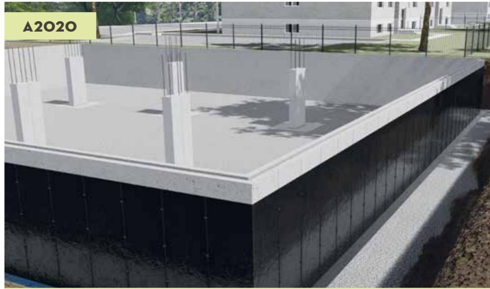
Lors de la construction du bâtiment, avant que le remblai de terre soit effectué, une protection contre l'humidité est toujours ajoutée sur la face extérieure des fondations sous le niveau du sol. Selon la nature du terrain, différentes techniques sont retenues: enduit bitumineux, membrane liquide, etc. La protection est complétée par l'installation d'un tuyau de drainage et un remblai de pierre concassée au niveau de semelles des murs de fondation au périmètre du bâtiment.
