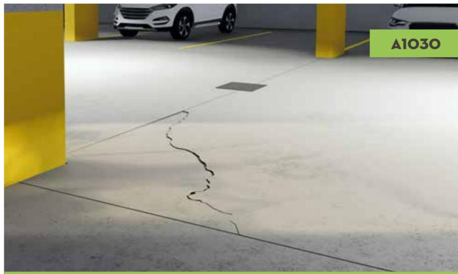
Les fissures supérieures à 3,2 mm (1/8 po) présentant un affaissement ou un dénivelé de part et d'autre de la fissure, et celles actives (en constante expansion) peuvent être attribuables à différents facteurs.
