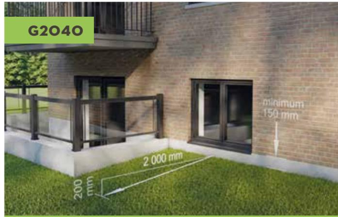
Un dégagement d'au moins 150 mm (6 po) doit être respecté entre le niveau du sol fini au pourtour des murs de fondation et le dessus de ceux-ci. En présence de revêtement extérieur sensible à l'humidité, le dégagement requis doit être d'un minimum de 200 mm (8 po).
