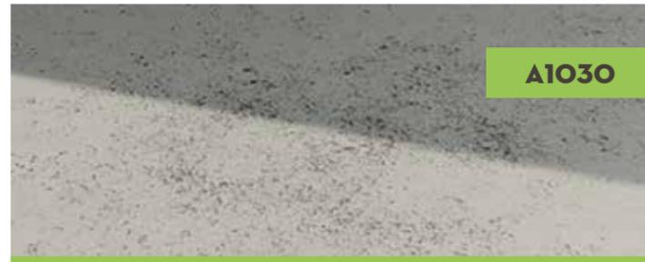
Les défauts de surface, tels que l'écaillage, l'effritement ou la poussière de béton, engendrent une diminution de la résistance superficielle de la dalle de béton et peuvent avoir plusieurs causes principalement occasionnées au moment de la mise en place de la dalle, de la finition ou de la cure du béton.
